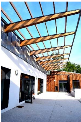
Foyer d'Hébergement Foyer Eclaté « La Bégude »
